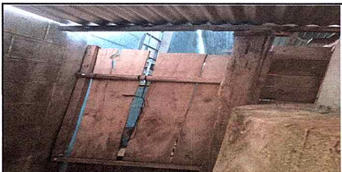
Foto 5: instalacion de lavamano del centro educativo,
