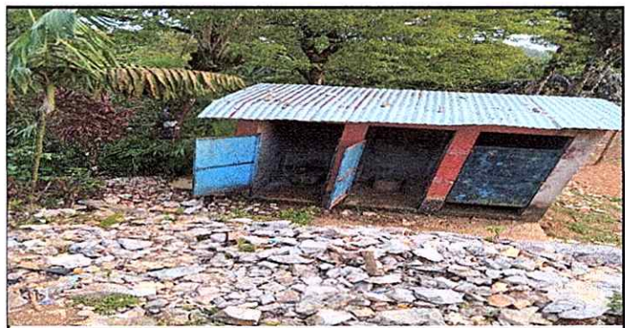
Foto 6: Sustitución de láminas de las letrinas, mantenimiento de puerta y cambio de pintura interior y exterior
