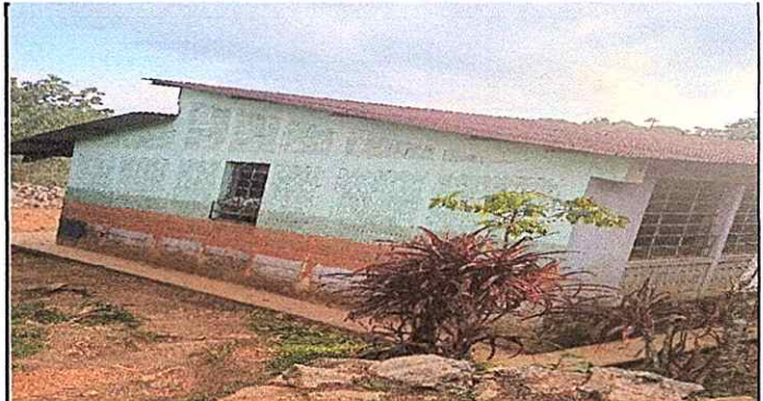
Foto 2: cambio de pintura de pared interiores y exteriores
