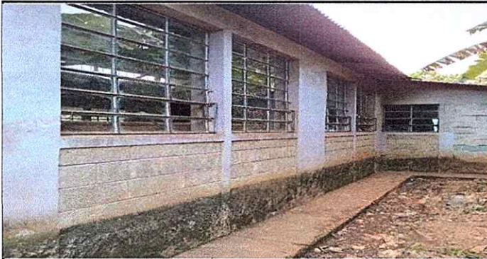
Foto 3: Mantenimiento estructuras metálicas de puertas y vidrios.
