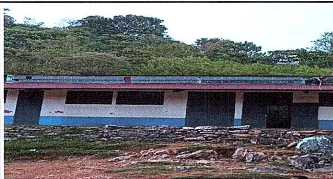
Foto 1: Aula multigrado de Primero, Segundo, Tercero, Cuarto, Quinto y Sextos. Sustitución de cubierta de lámina.
