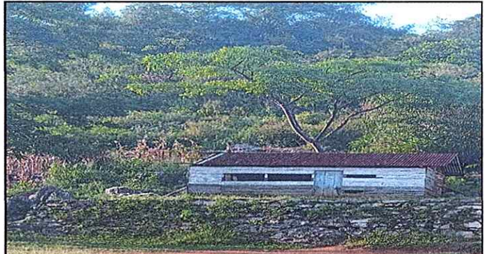
Foto 4: sustitución de cubierta de láminas de la cocina y piso
